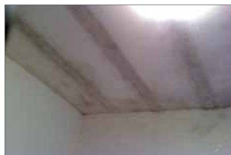
Estas imágenes muestran claramente que los puntos fríos provocados por puentes térmicos coinciden exactamente con el desarrollo del moho.
